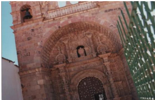
Foto N°1: Vista detalle de fachada principal, desde el atrio, con acceso desde la calle Héroes del Chaco.
